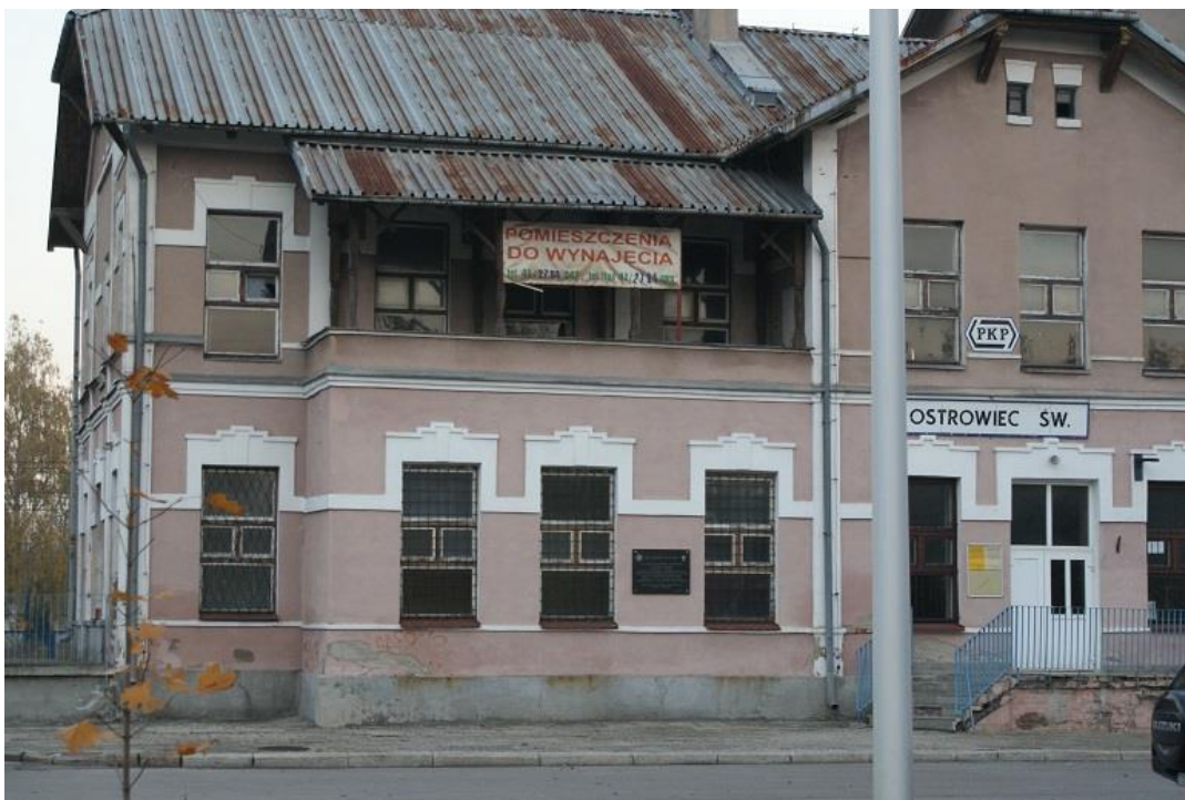
Fot. 20. Obiekt dworca kolejowego
