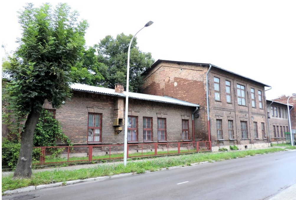
Fot. 30. Byłe Laboratorium zakładów ostrowieckich i szpital dla pracowników, planowany budynek Centrum Tradycji Hutnictwa
