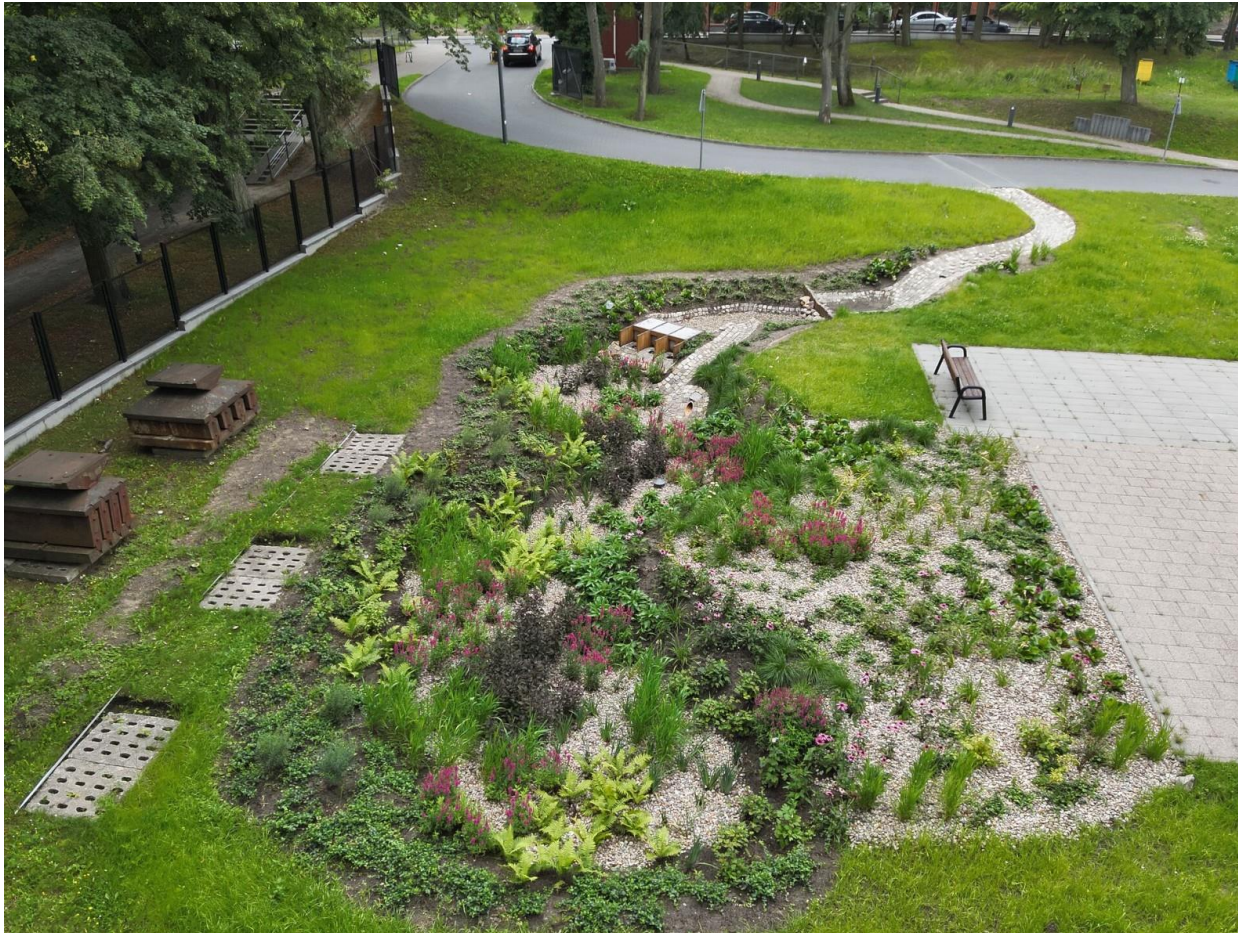
Ogród deszczowy Politechniki Gdańskiej
