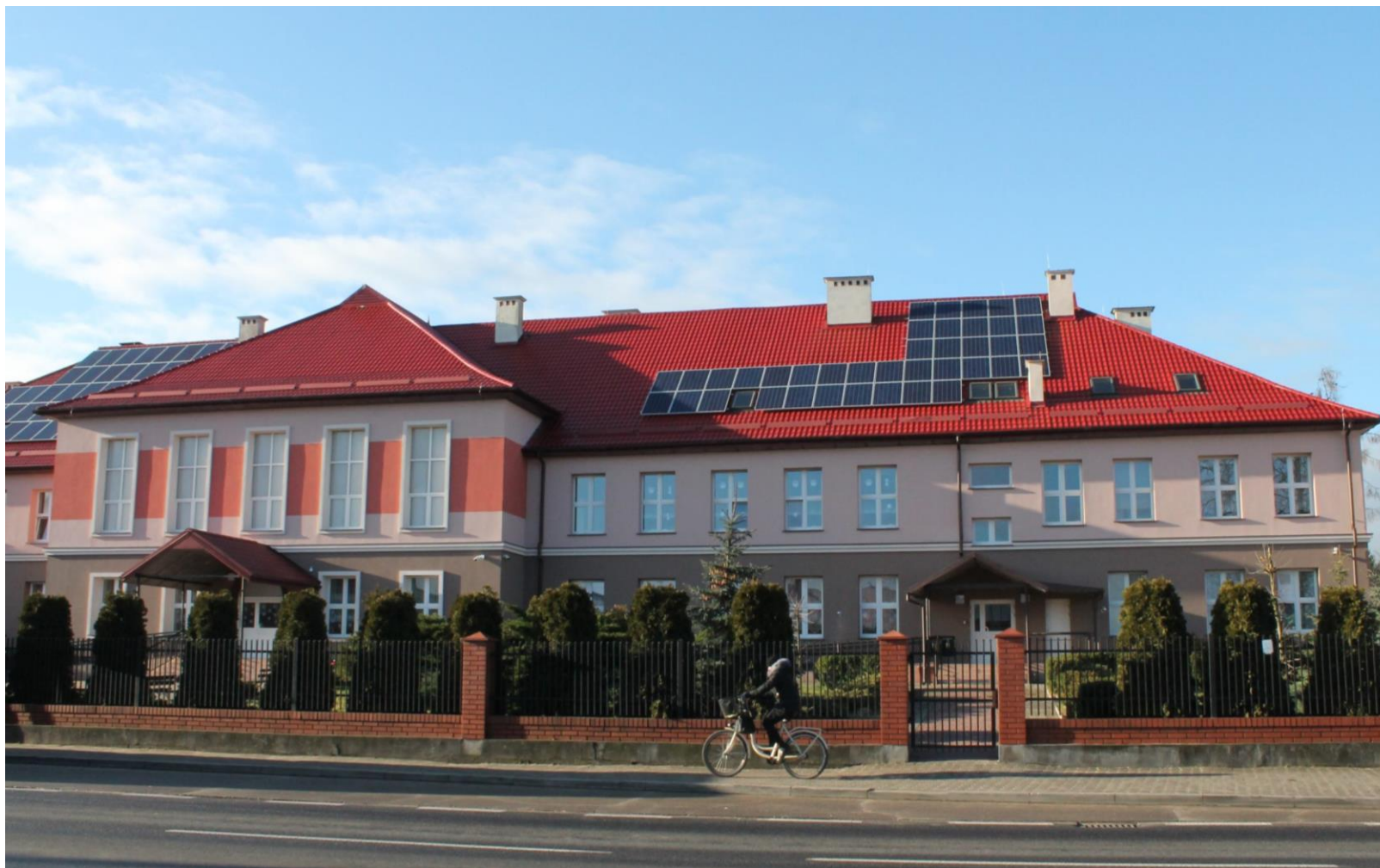
Szkoła Podstawowa w Odrzywole po termomodernizacji
