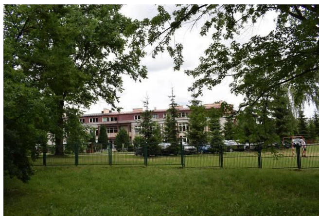
Fot. 11. Centrum Kształcenia Zawodowego i Ustawicznego przy ul. Adama Mickiewicza
