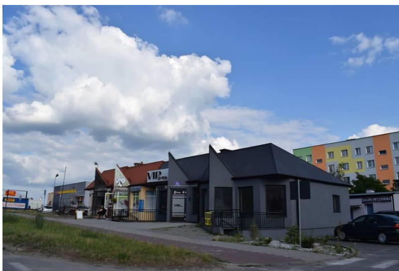
Fot. 23. Zabudowa mieszkaniowo-usługowa na terenie os. Rosochy (od strony ul. 11-go Listopada)
